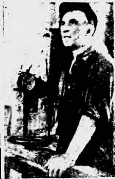
Стахановец-сталевар рудо-ремонтного завода т. Нарсанов, систематически перевыполняет норму. Фото В. Ковалюхина.
